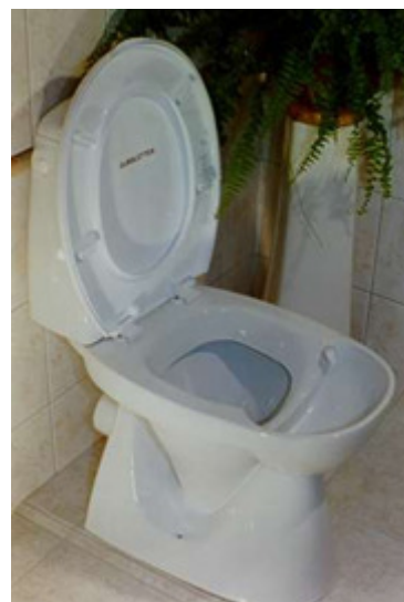
Ex på urinseparerande wc Dubbletten
