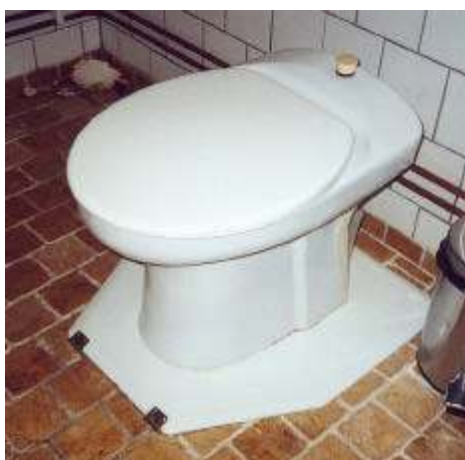
Figur 15. Olika typer av urinsorterande torrtoaletter som finns att köpa i Sverige och Danmark - WM Classic, Separett Villa samt Separera NE från Swedish Ecology. (Foto: Ebba af Petersens, bild a, samt www.separett.se och www.mulltoa.se .)
