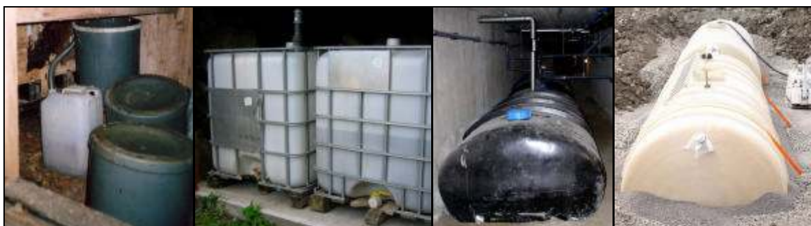
Figur 21. Tankar i olika storlekar för uppsamling av urin. Från vänster: 25 l plastdunk för utedass, 1 m 3 IBC-behållare på pall, 4 m 3 tank för flerfamiljshus placerad i källare samt 18 m 3 tank för bostadsområde. (Foto: Ebba af Petersens (bild 1), Verna Ekologi AB (bild 2-4).)
