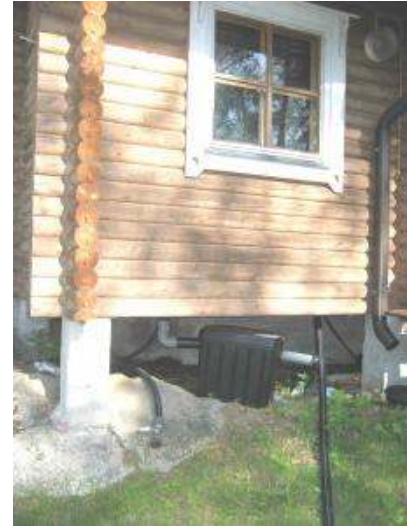
Placeras ovan eller i marken, vid vinterbruk måste den isoleras.
